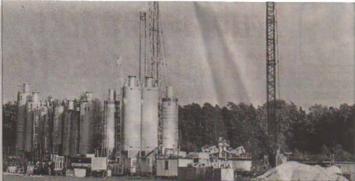
Baustellensilhouette auf der Giftdeponie, wo das Testfeld für die Umschließung liegt: In den Silos befinden sich Tonmehl, Bentonit, Zemente und andere Stoffe, die dem Verfahren beigegeben werden. An dem Kran hängt eine Fräse, die sich in einer Breite von 2,50 Metern bis 30 Meter tief in den Tonstein „beißt“. Dort wird das Gestein zerkleinert, an die Oberfläche gepumpt und in einer Anlage von den beigegebenen Stoffen befreit. Der Ton wird auf der Baustelle wieder verwendet. Foto: Reckleben
