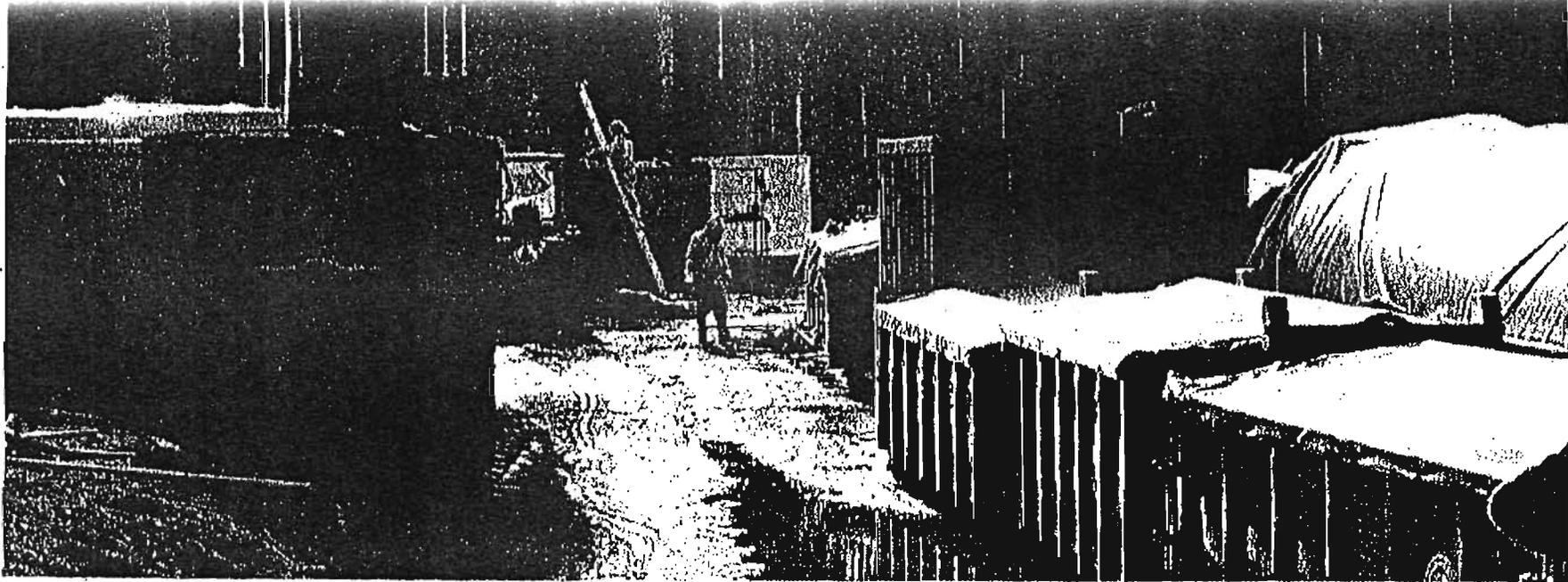
Auf dem Deponiegelände stehen Container als Giftmüllbehälter herum. Oberflächenwasser wird in Hochbehälter (hinten) gepumpt, gereinigt und in Tankwagen abtransportiert.
