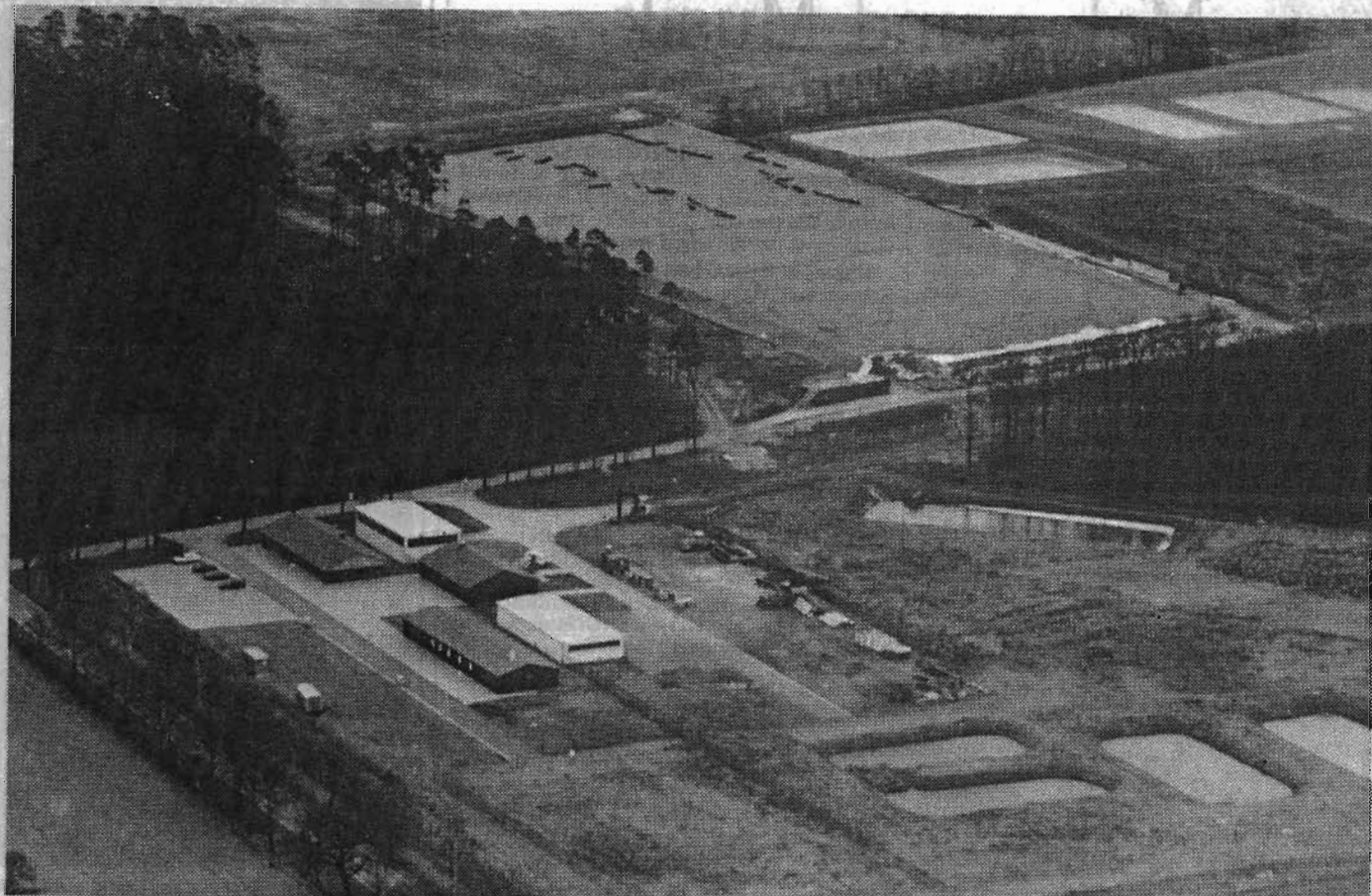
Der vordere Teil der Sonderabfalldeponie Münchehagen aus der Luft betrachtet: Dort wird gegenwärtig die Altdeponie (Mitte) mit einer vorläufigen Abdeckung versehen. Auf eine besondere Geo-Textilplane wurde eine Kiesschüttung aufgebracht, in die ein Gas- und Deponiewasser-Erfassungssystem eingelassen ist. Darüber wurde wieder eine Geo-Textilabdeckung sowie eine zwei Millimeter starke Kunststoffdichtungsbahn gezogen und auf diese eine weitere Kiesschicht geschüttet.
