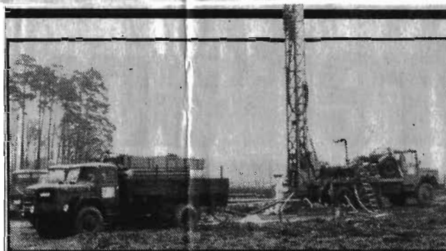
Ein Bohrwagen holt aus der Deponie Münchehagen Erdproben. Dabei wurde festgestellt, daß Gifte im Grundwasser aus dem Gelände herauswandern.
