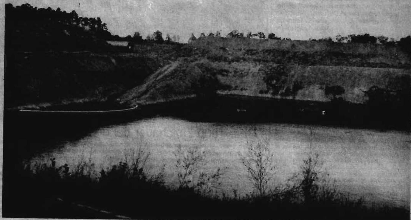
Aus der Böschung am linken Bildrand tritt Öl ins Polder 4 der Sondermülldeponie Münchehagen ein. Gestern installierte der Landkreis eine standardgemäße Ölsperre (links, vor der Abfuhr). Um die Pumpe (rechts auf dem Wasser) liegt ebenfalls eine Ölsperre, damit sie beim heute wieder beginnenden Abpumpen des Deponiewassers kein Öl aufnimmt, auch wenn sie, so der Kreis, gar kein Oberflächenwasser absaugt. Foto: Lange
