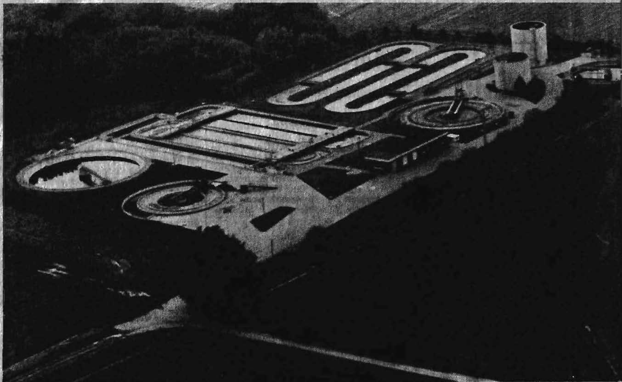
Strenge Sicherheitsvorkehrungen fordert die Junge Union Marktohe für den Fall, daß die Deponieabwässer aus Münchenhagen in Lemke gek werden sollten. Unser Bild zeigt die Lemker Kläranlage aus der Vogelperspektive. Luftfoto: Sommerfeld, freigez. BR Braunschweig Nr. 5471
