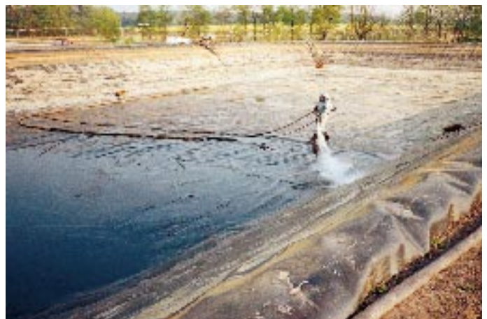
Abb. 22: Mitarbeiter unter Vollschutz bei der Stapelteichreinigung
