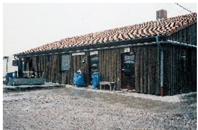
Abb. 3: Ansicht der Schwarz-Weiß-Schleuse, aus der Sicht des kontaminierten Bereiches
